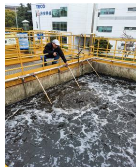
员工先将曝气管用软管连接镀锌管对准无法排泥阀的入口处进行曝气，将底部沉积污泥曝松散，然后再进行正常排泥操作，但任无法正常排泥
