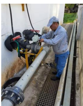
拆掉电动阀门，将工水与排泥管连接，进行反冲洗，同时配合入口处曝气，重复几次后管路疏通，排泥正常
