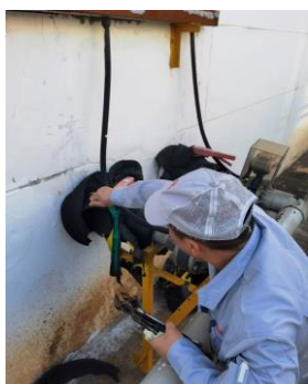
员工关闭排泥管手阀
